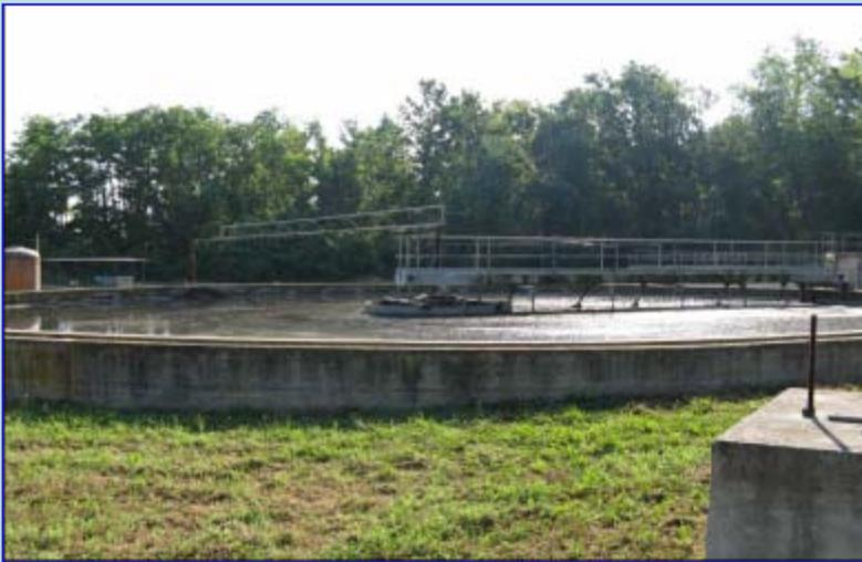
Il fango depositatosi sul fondo del decantatore viene, tramite pompe, in parte ricircolato nelle vasche di ossidazione con lo scopo di mantenere in queste la concentrazione ottimale di microrganismi ed in parte, denominato "fango di supero", inviato al trattamento fanghi.
