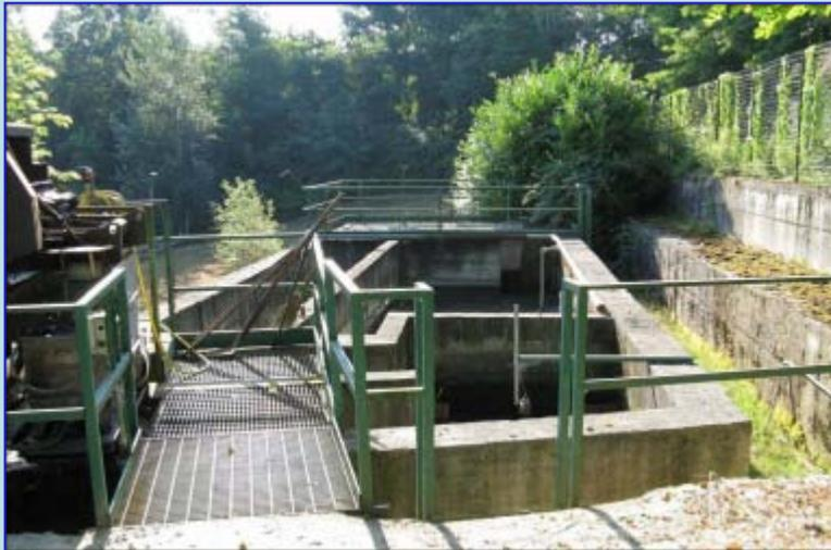
La sgrigliatura è eseguita a monte di altri trattamenti e ha come scopo principale la rimozione di corpi e/o oggetti grossolani (legno, stracci, materiale vario) trasportati dalle acque reflue al fine di evitare il danneggiamento e l'inquinamento delle fasi successive.
