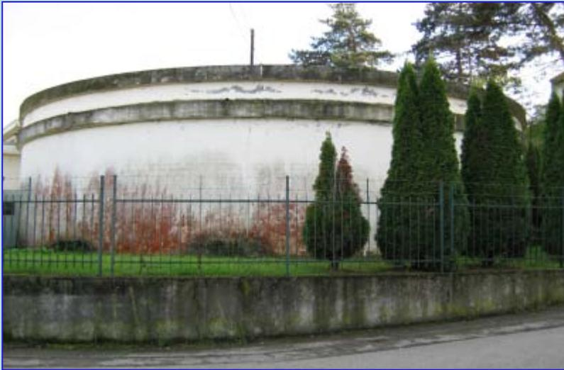
Il Serbatoio di Valle Po è posto in corrispondenza degli impianti di trattamento. Esso ha una capacità di circa 500 mc.
