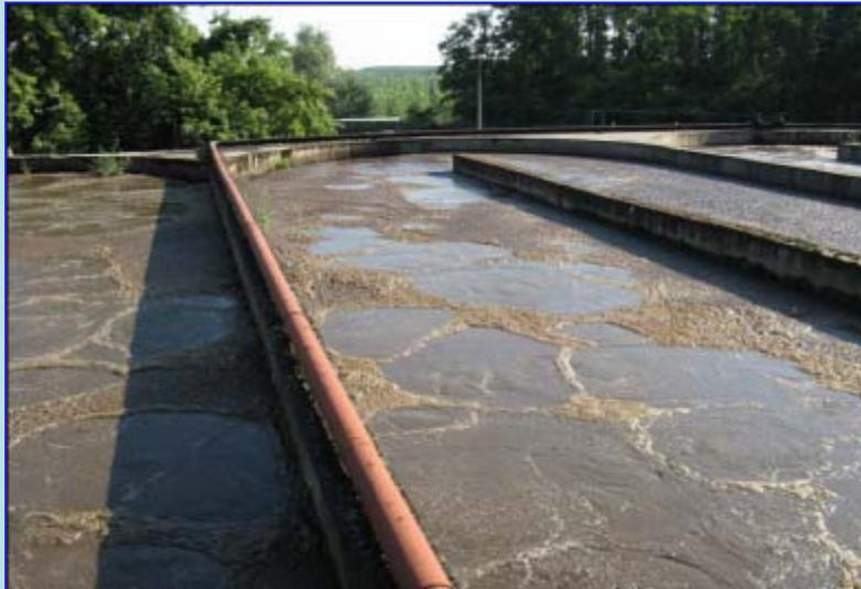
A mezzo di un sistema di compressione e distribuzione di aria in microbolle viene fornita l'aria necessaria alla metabolizzazione delle sostanze organiche ed all'ossidazione dell'ammoniaca presente nel liquame.
